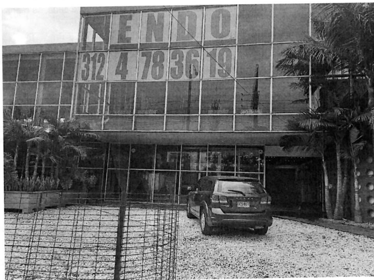
Foto No. 15. Ventanas hacia la calle.
