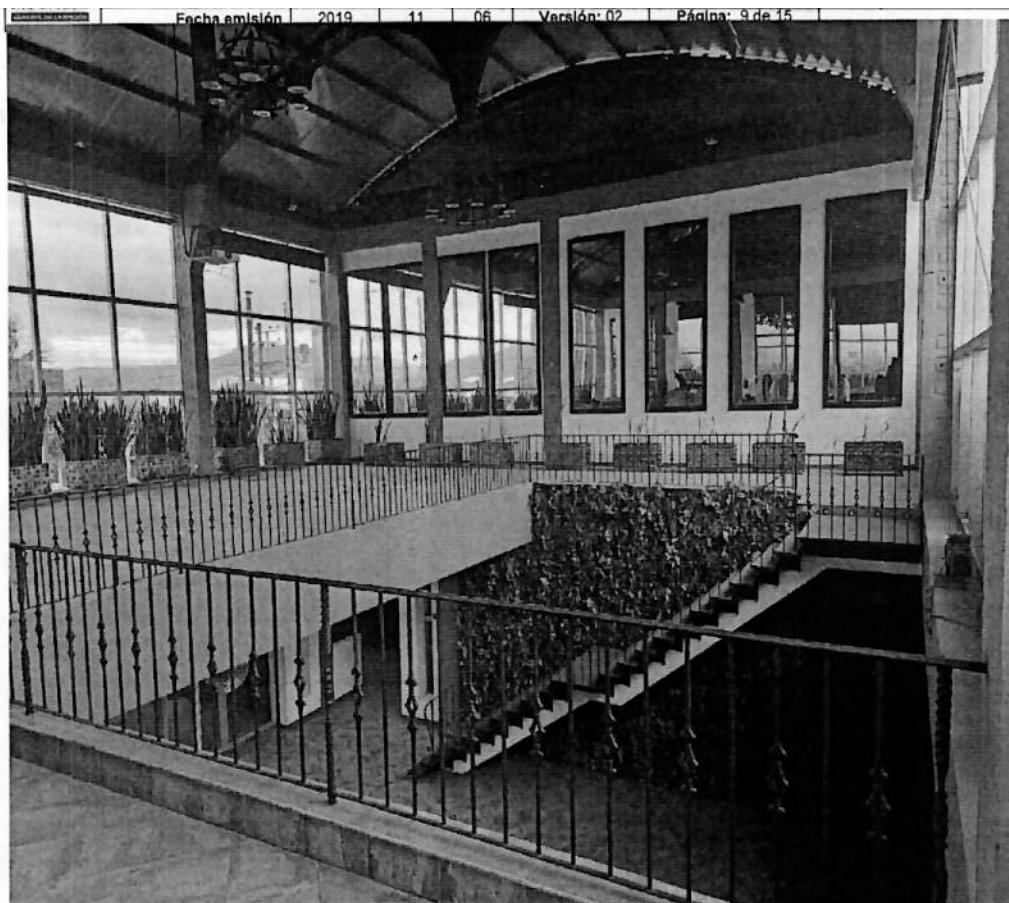
Foto No. 12. Segundo piso.
