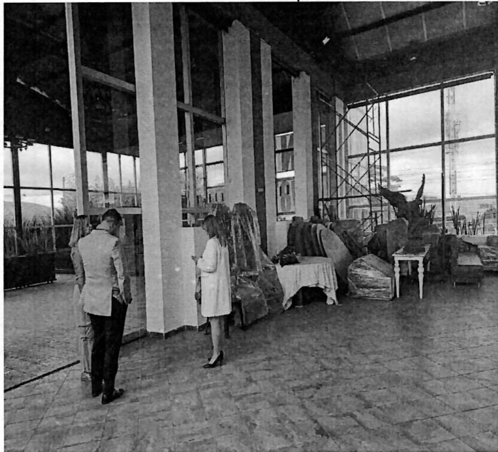
Foto No. 7. Salón piso 1.
