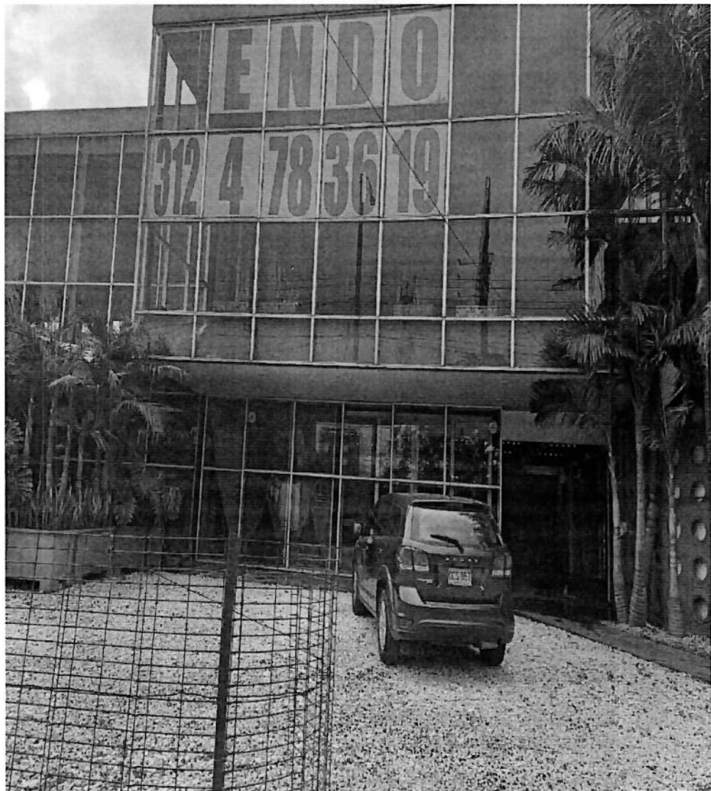
Foto No. 2. Ingreso Peatonal.
