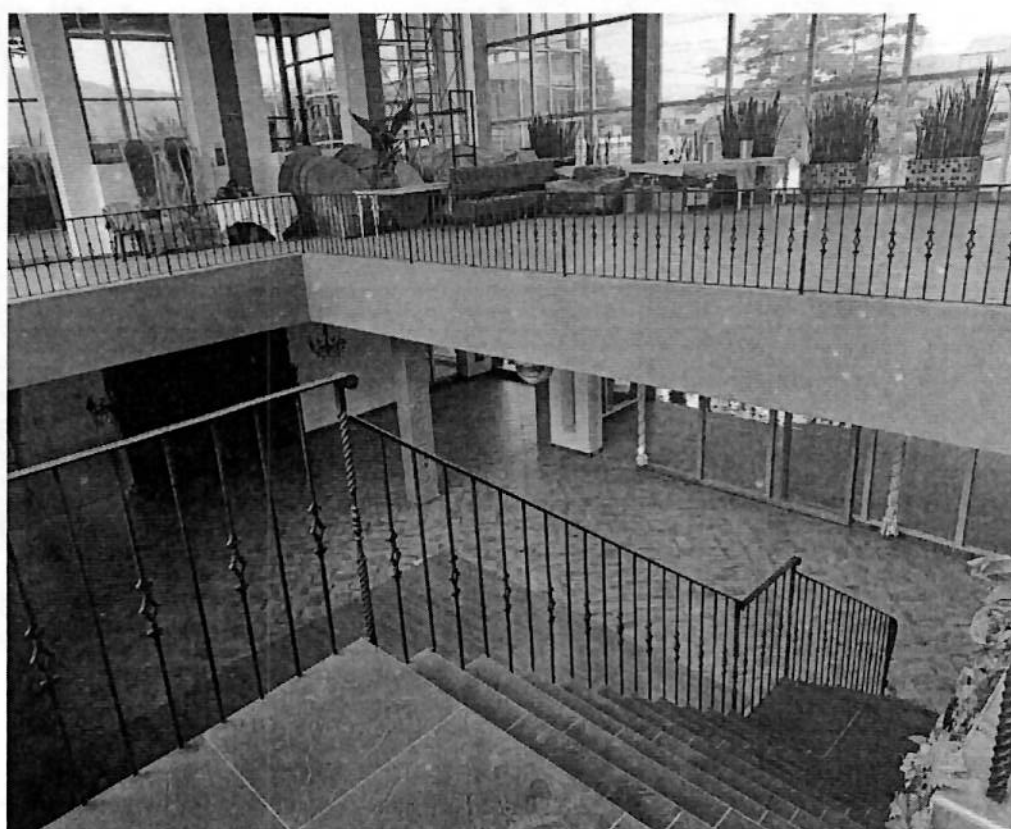
Foto No. 11. Vista hacia el primer piso.
