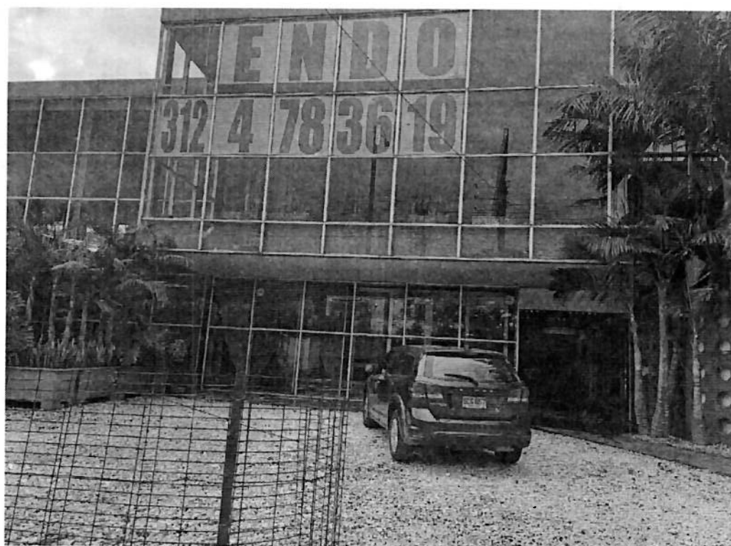
Foto No.15. Ventanas hacia la calle.
