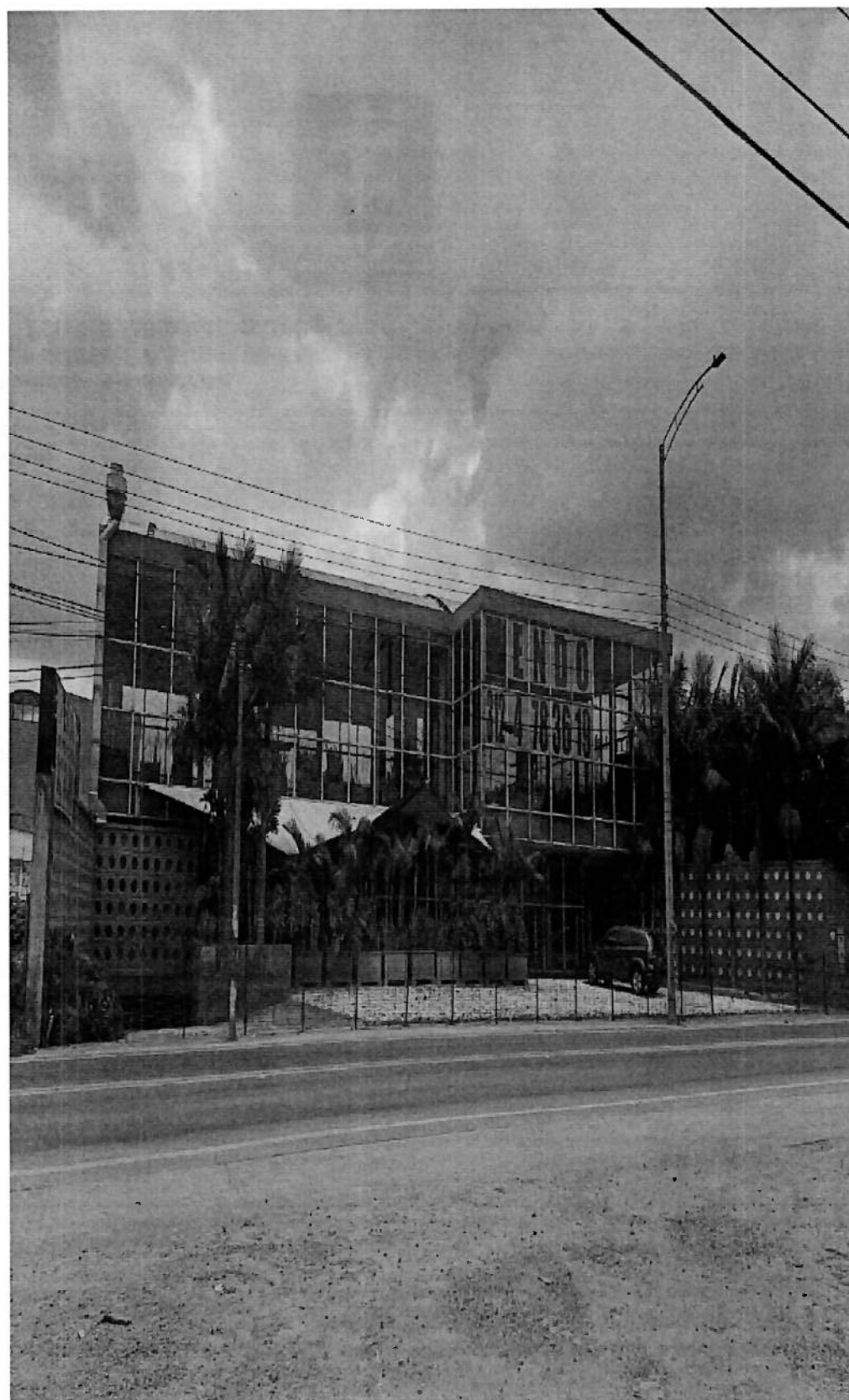
Foto No. 1. Fachada inmueble.
