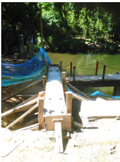
Imagen 21. Anclajes de apoyo en la pantalla #2.
