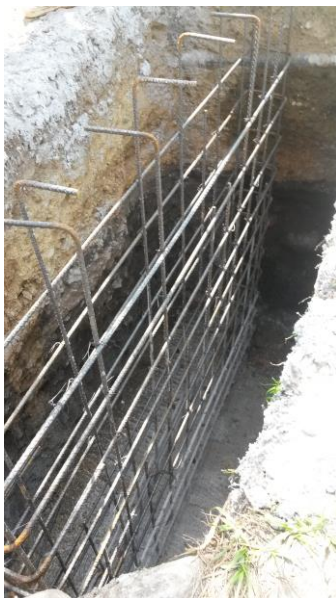
Imagen 14. Amarre de hierro #4 para la pantalla de la estructura #1.
