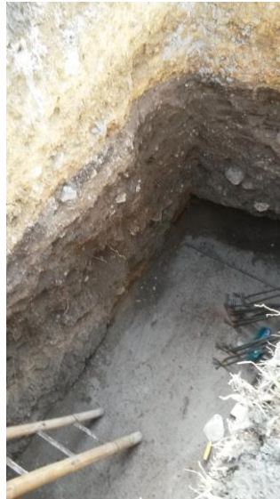
Imagen 17. Concreto Ciclópeo para la zapata #1.
