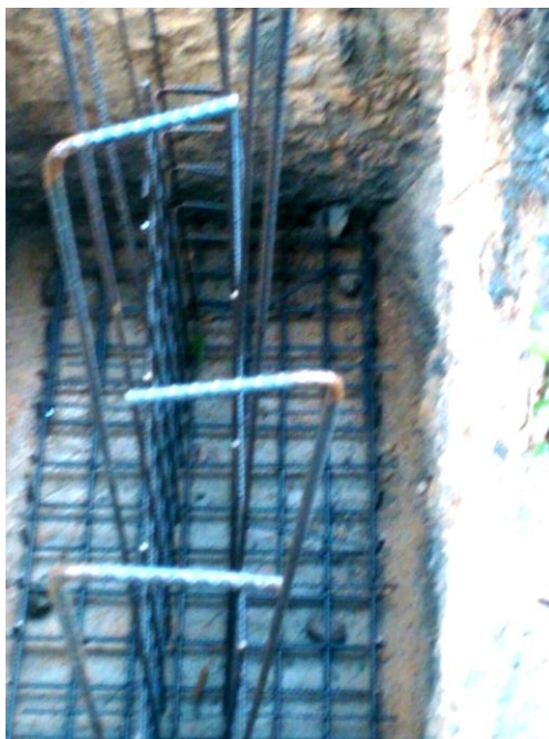
Imagen 15. Amarre de hierro #5 para la zapata #2.
