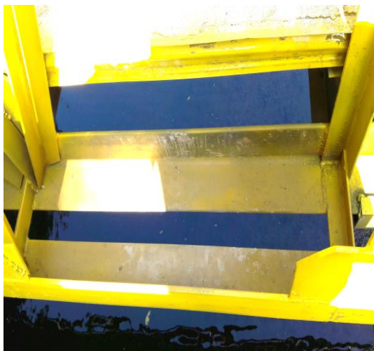
Imagen 35. Láminas para bordes placa metaldeck.
