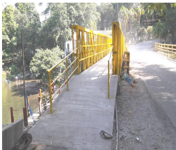
Imagen 26. Rampa de acceso #2.
