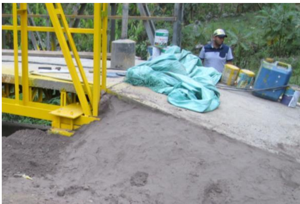
24. APROXIMACIONES EN CONCRETO
