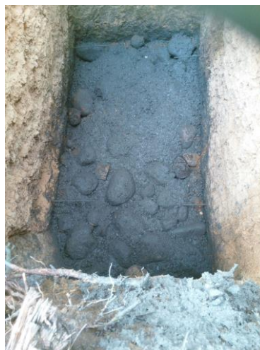
Imagen 18. Fundida del concreto Ciclópeo.
