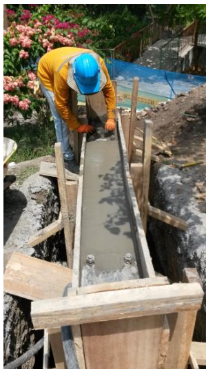
Imagen 10. Fundida con concreto clase D 4000 PSI para la pantalla #1.
