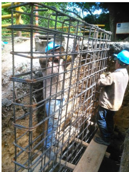
Imagen 16. Amarre de hierro #4 para la pantalla de la estructura #2.
