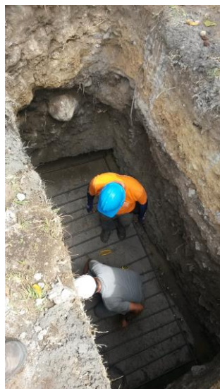
Imagen 13. Amarre de hierro #5 para la zapata #1.
