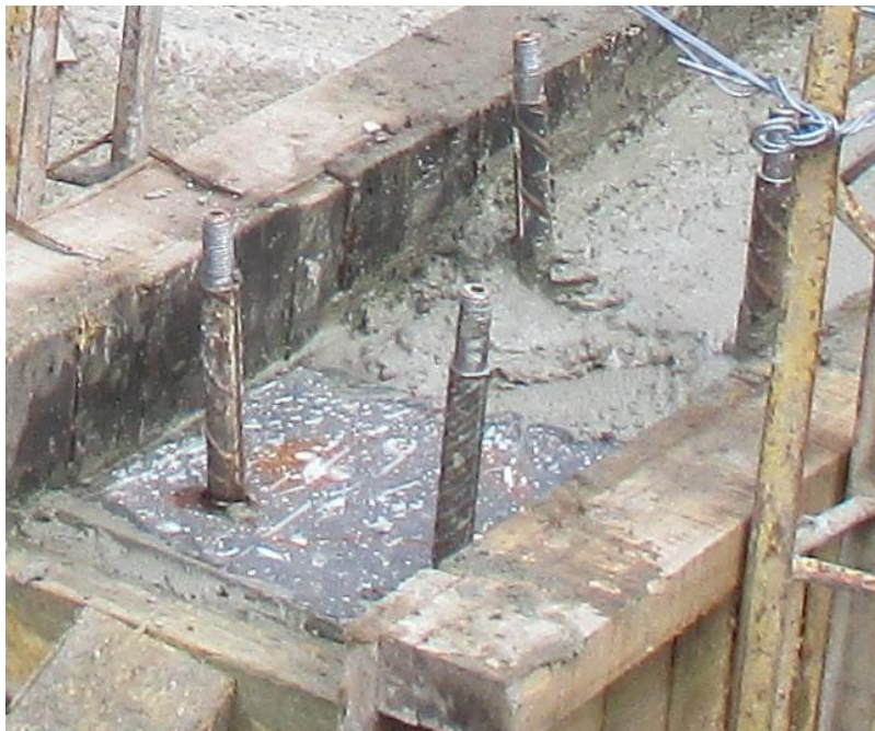
21. ANCLAJES DE APOYO
