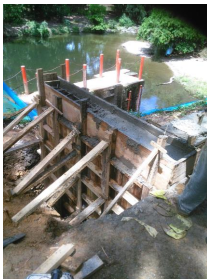
Imagen 11. Fundida con concreto clase D 4000 PSI para la pantalla #2.
