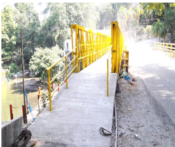
Imagen 35. Baranda de acceso # 1.
