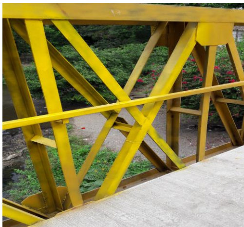
Imagen 19. Angulo diagonales y verticales de 2 1/2" x 2 1/2" x 1/4".
