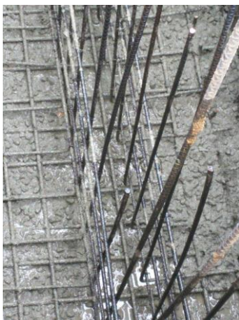
Imagen 9. Fundida con concreto clase D 4000 PSI para la zapata #2.
