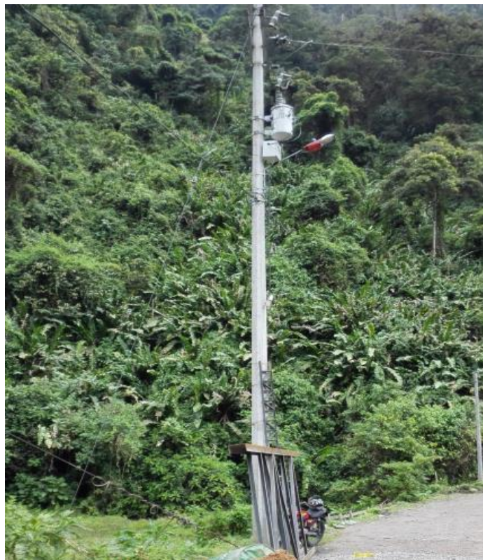
25. REUBICACION DE POSTE
