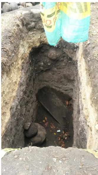
Imagen 5. Excavación a mano en la ubicación de la zapata #1.
