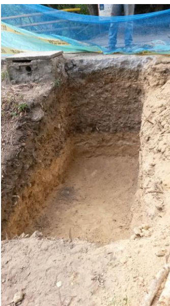
Imagen 6. Excavación a mano en la ubicación de la zapata #2.
