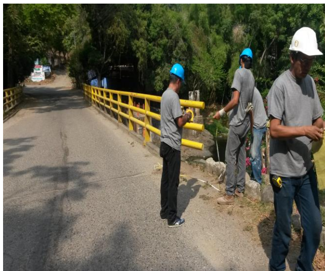
Imagen 4. Replanteo de la obra.
