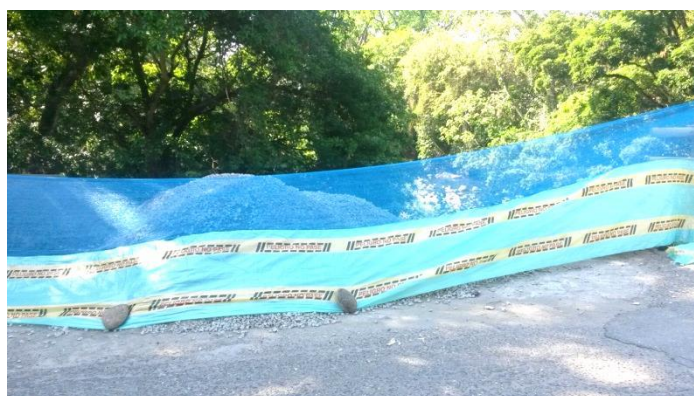
Imagen 2. Cerramiento para los materiales pétreos ubicados en la obra.
