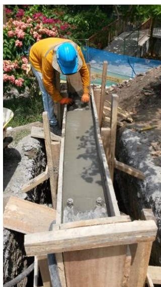
Imagen 22. Anclajes de apoyo en la pantalla #1.
