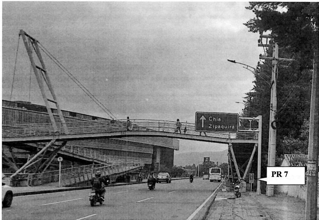
Ubicación del puente peatonal existente
