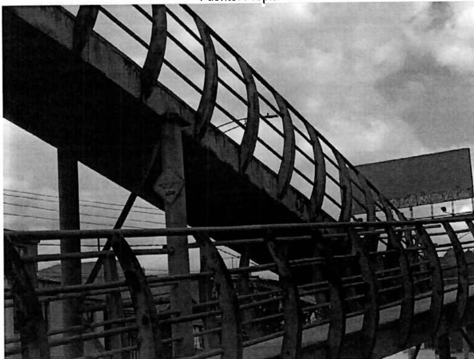
Fotografía 10 Rampa de acceso norte Fuente: Propia
