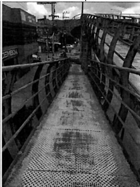
Fotografía 8 Rampa de acceso norte Fuente: Propia
