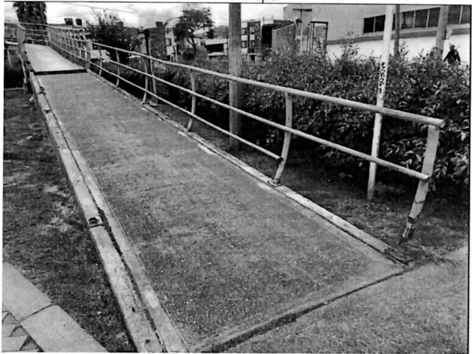
Fotografía 5 Rampa de acceso nororiental Fuente: Propia
