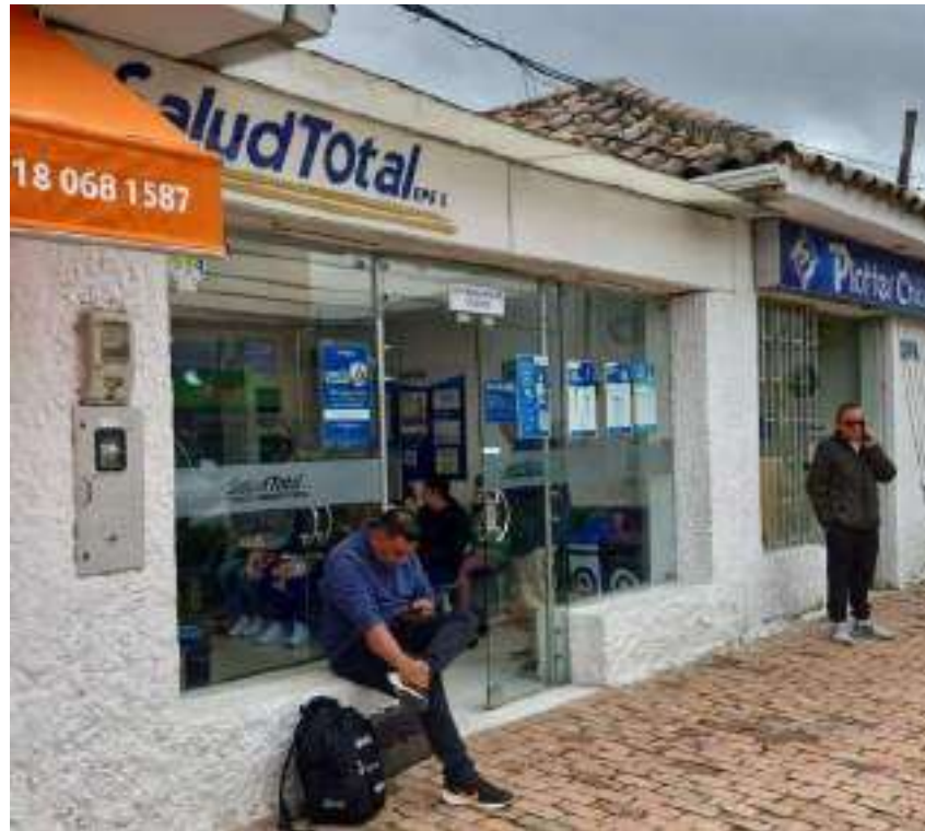
Anexo 1. (Ingreso a instalaciones SALUD TOTAL)
