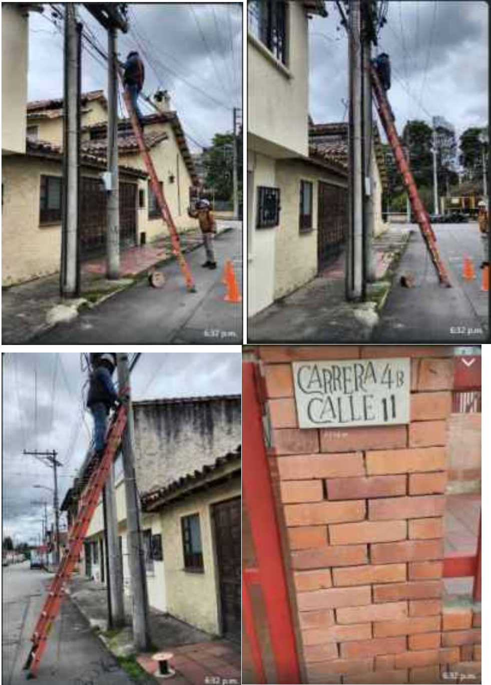
Instalación kit de cámaras junta de Acción comunal El Refugio. Carrera 4b Calle 11 08/09/15-09-2025
