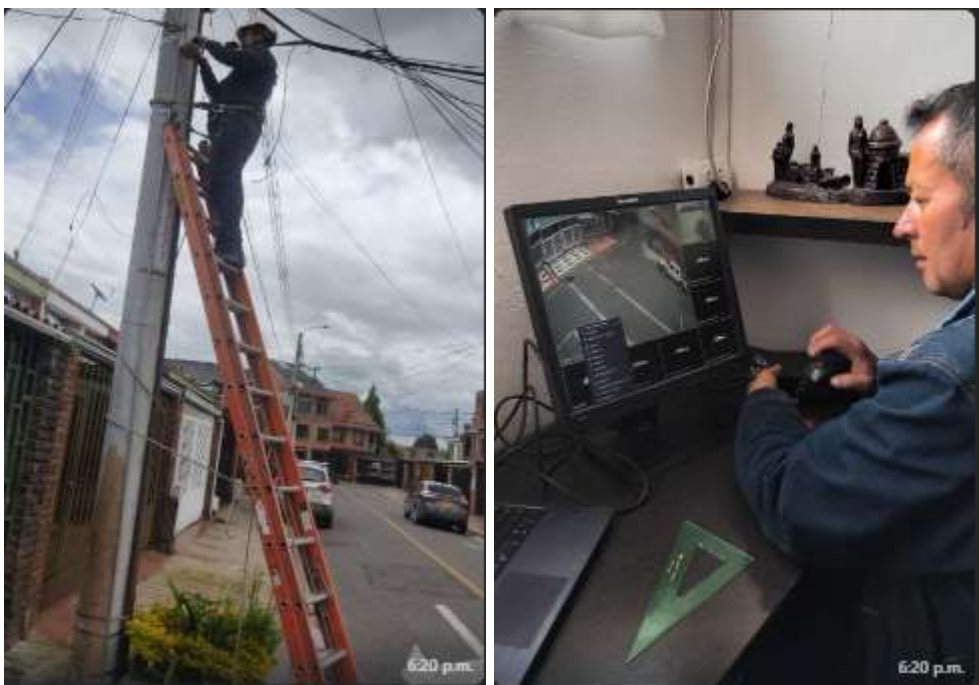
Mantenimiento de cámaras y cambio de cable utp. En IBARO II 19-05-2025
