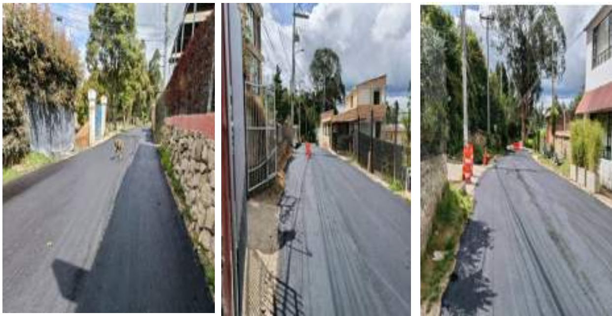
1.30 Slurry en el camino El Cerro entre el Camino El Volador y Alejandría
