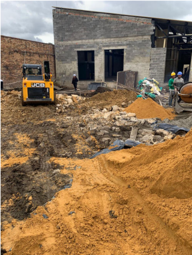
Fachada asojuntas estado actual, para realizar ajuste
