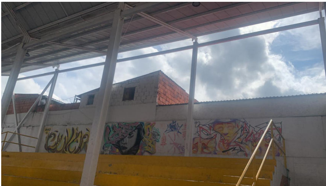
- Registro fotográfico revisión estado cubierta Calahorra
