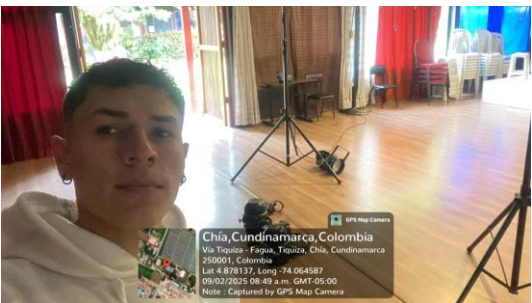
02/09/2025: Se realizó desmontaje y traslado de estructura de luces y luces del teatro barajas a la sede San Juan del Camino.
