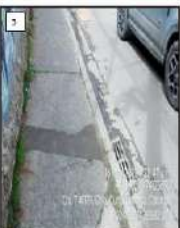
ANEXOS 1 y 2 se anexa intervención realizada en concreto reforzado en condiciones mínimas exigidas, fecha de verificación 14 de mayo de 2025.
