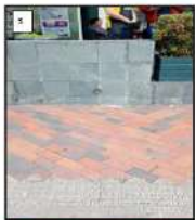
ANEXOS 1 y 2 se anexa intervención realizada en concreto reforzado en condiciones mínimas exigidas, fecha de verificación 14 de mayo de 2025.
