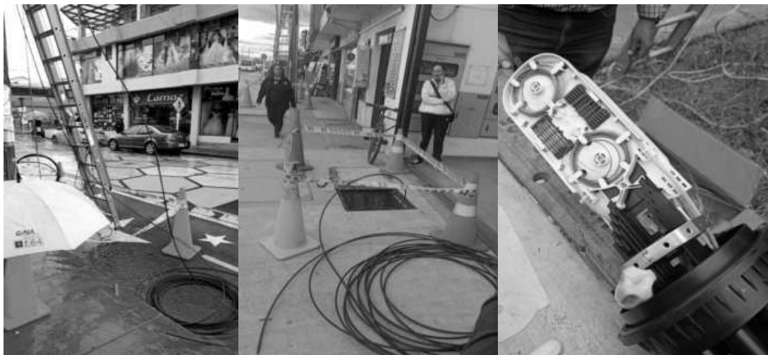
Figura 2: Tendido y empalme de la fibra óptica.
