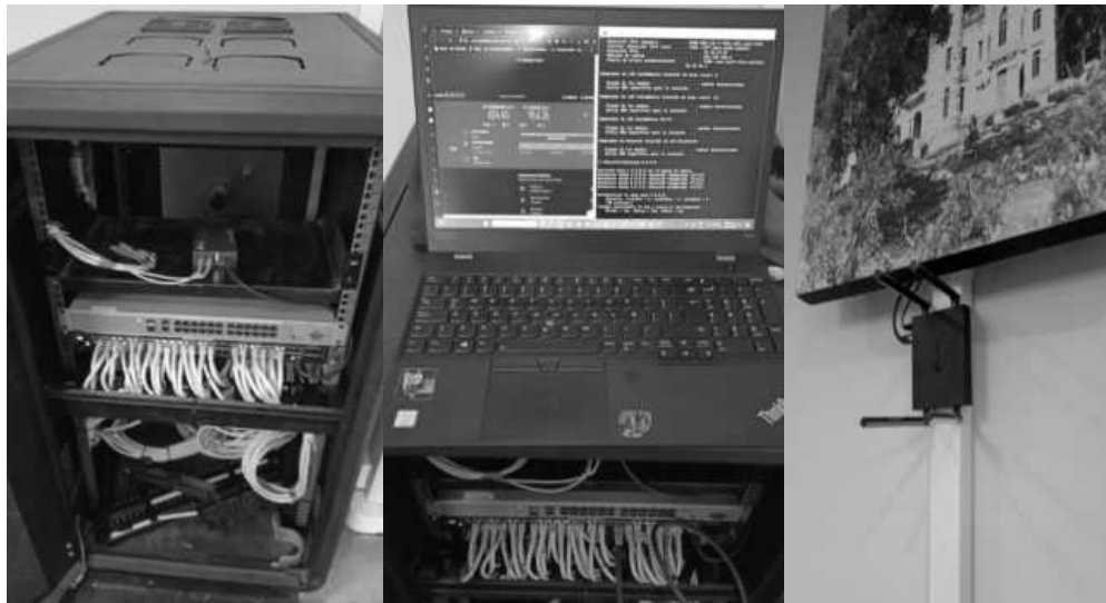
Figura 3: Instalación, Peinado y Pruebas de conexión y velocidad del servicio de internet.
