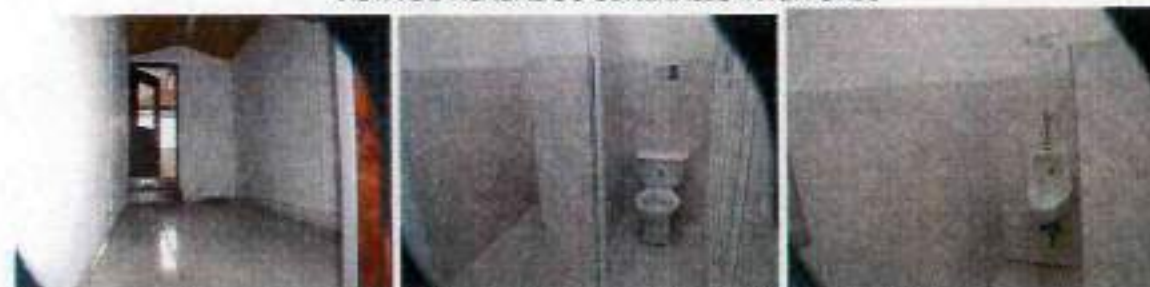
VISTA GENERAL ACABADOS DE LAS BATERIAS DE BAÑOS
